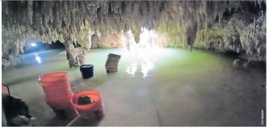
En el informe se detalla que al colocar los pilotes hubo afectaciones en las cavernas sobre las que corre el Tramo 5 Sur, como la caída de cemento en el agua.
